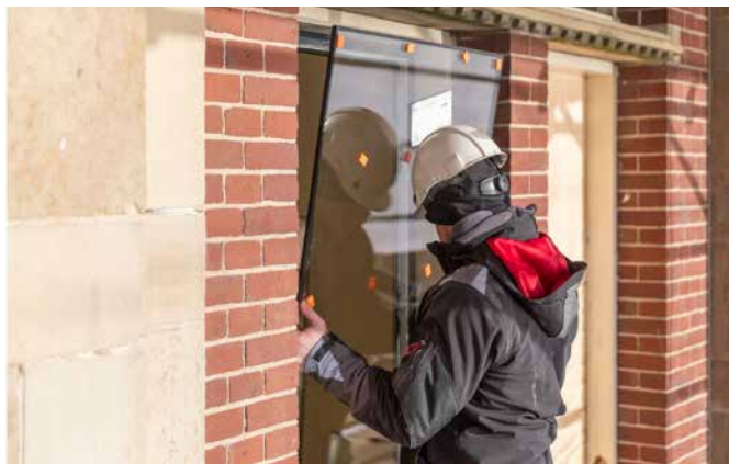
In de originele raamkozijnen werd dun glas met een hoge isolatiewaarde geplaatst.
