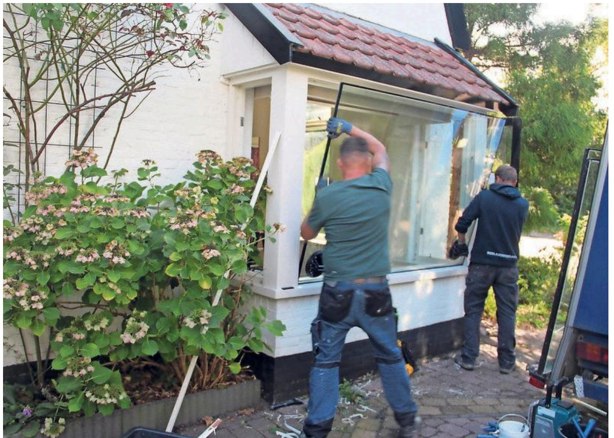
Het plaatsen van het glas
